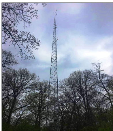
Der finale Aufbau: Oben die neuen Dipole, darunter die DAB-Antennen, unten ein Reserve-Notfall-Dipol
